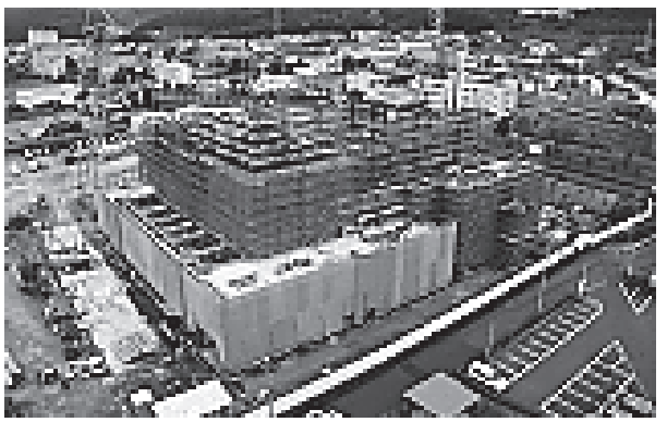
2017年11月20日 工事中ホール
